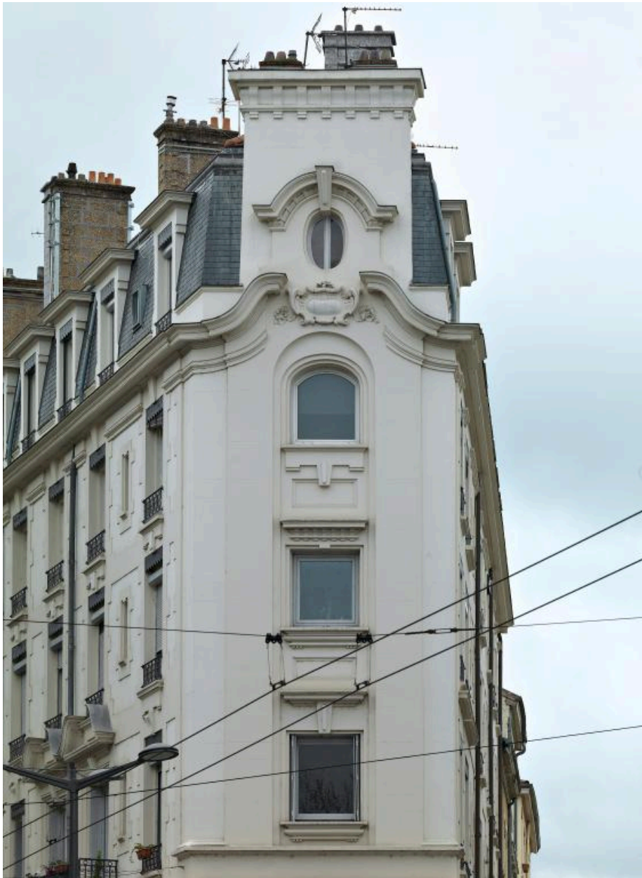
Détail du couronnement de l'édifice, sur l'angle en pan coupé
