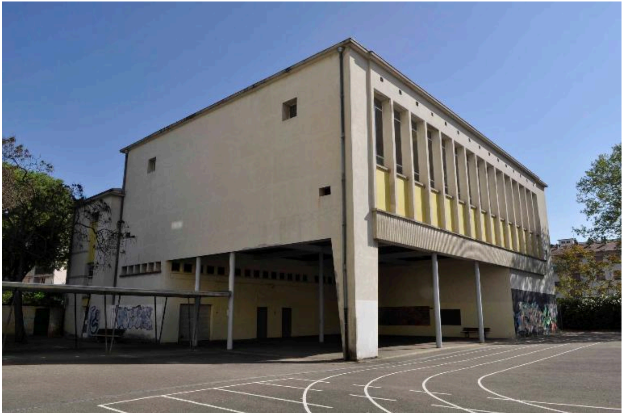
Gymnase, vue d'ensemble depuis le sud-ouest
