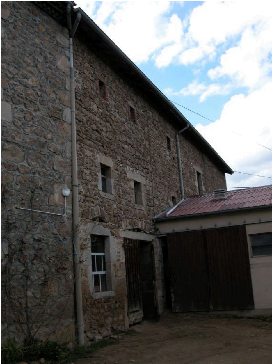
Vue d'ensemble de la grange-étable.
