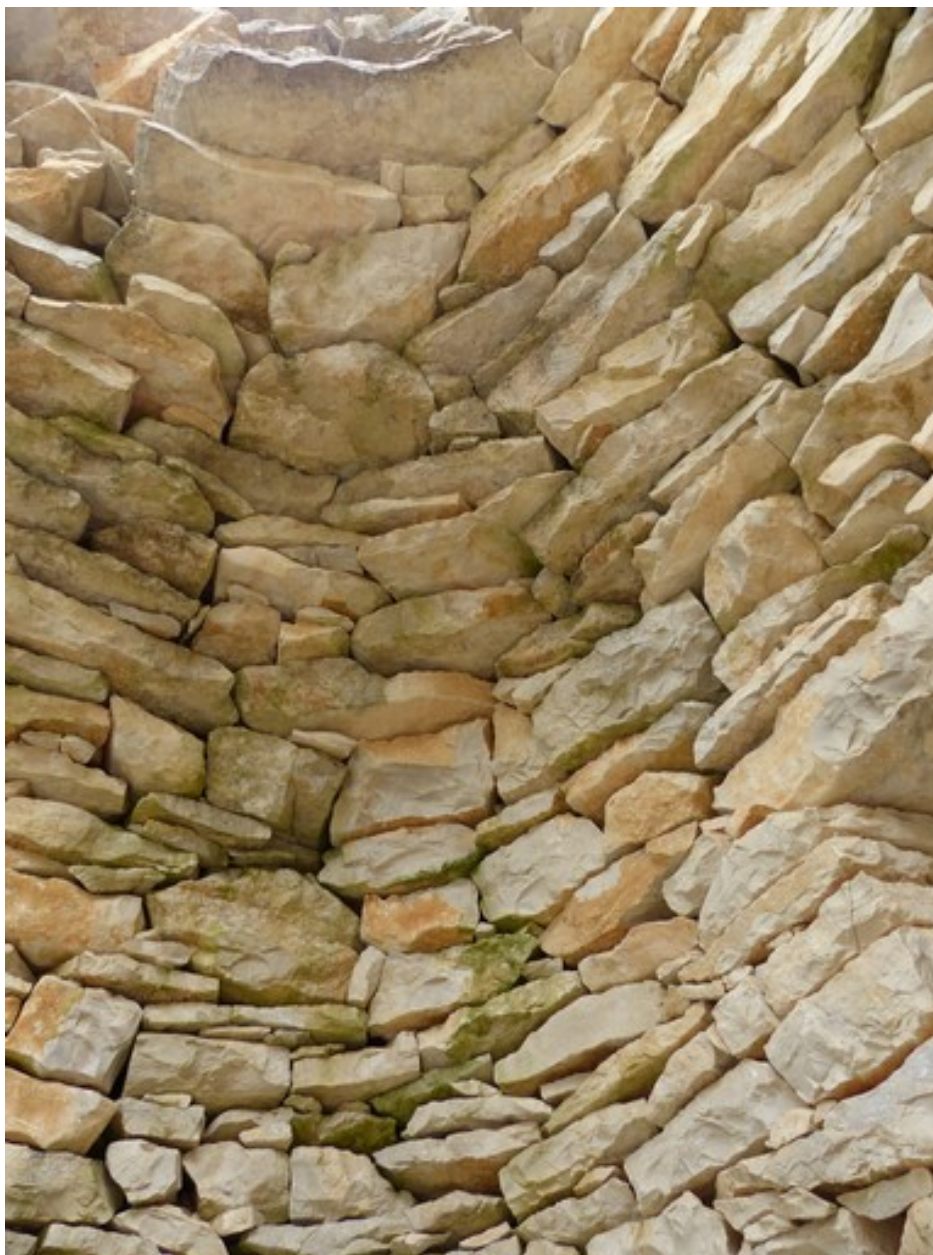
Angle nord-ouest, départ de l'encorbellement.
