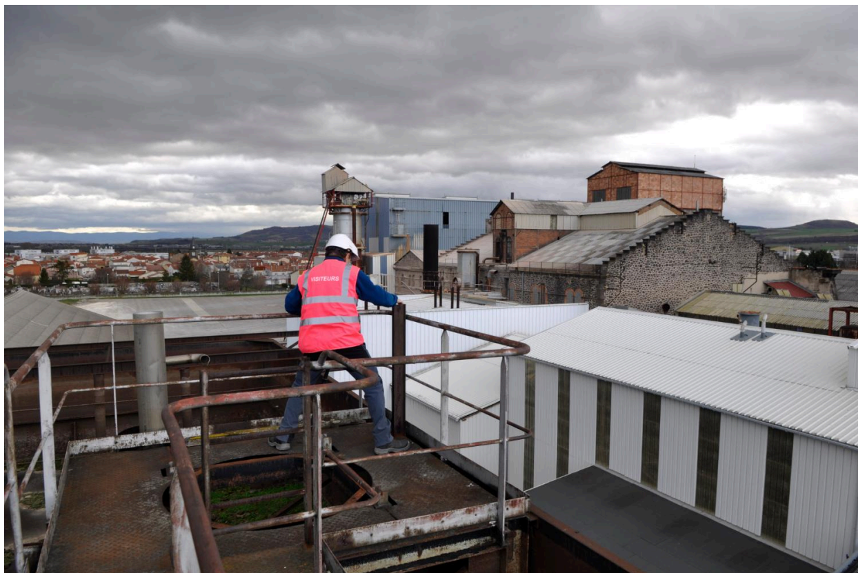
Vue de l'extérieur : détail toiture
