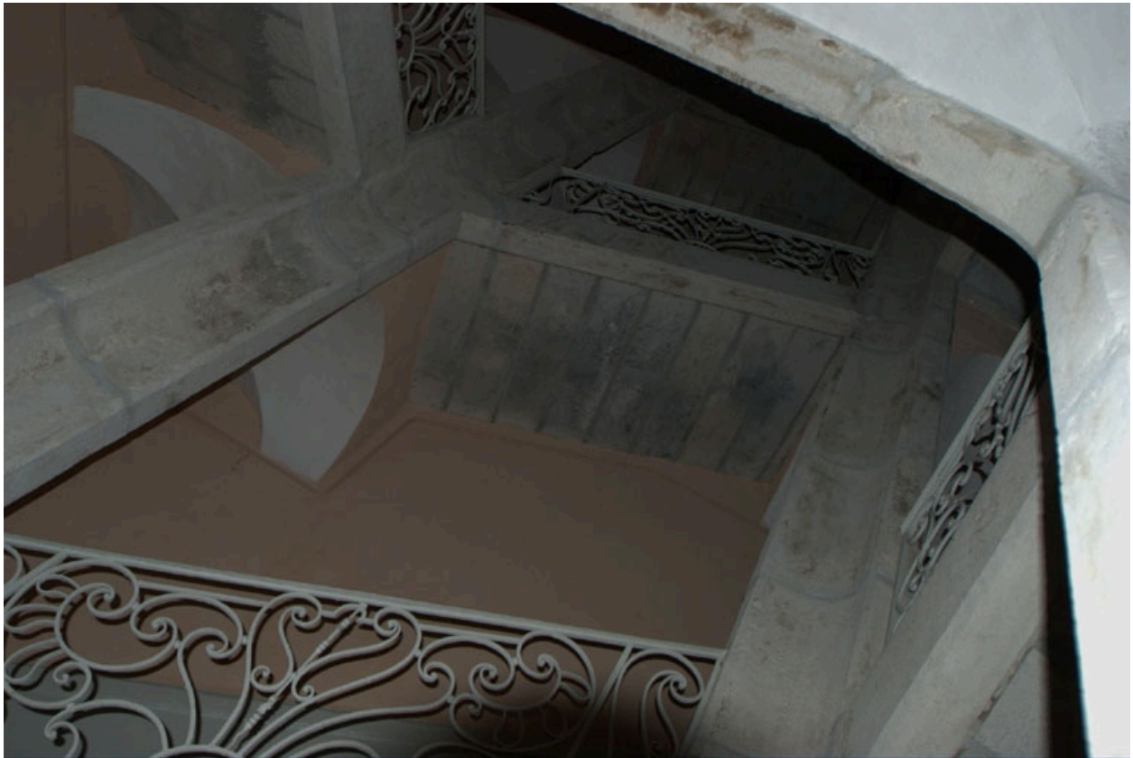
Détail escalier de l'immeuble de la rue Sainte-Marie-des-Terreux
