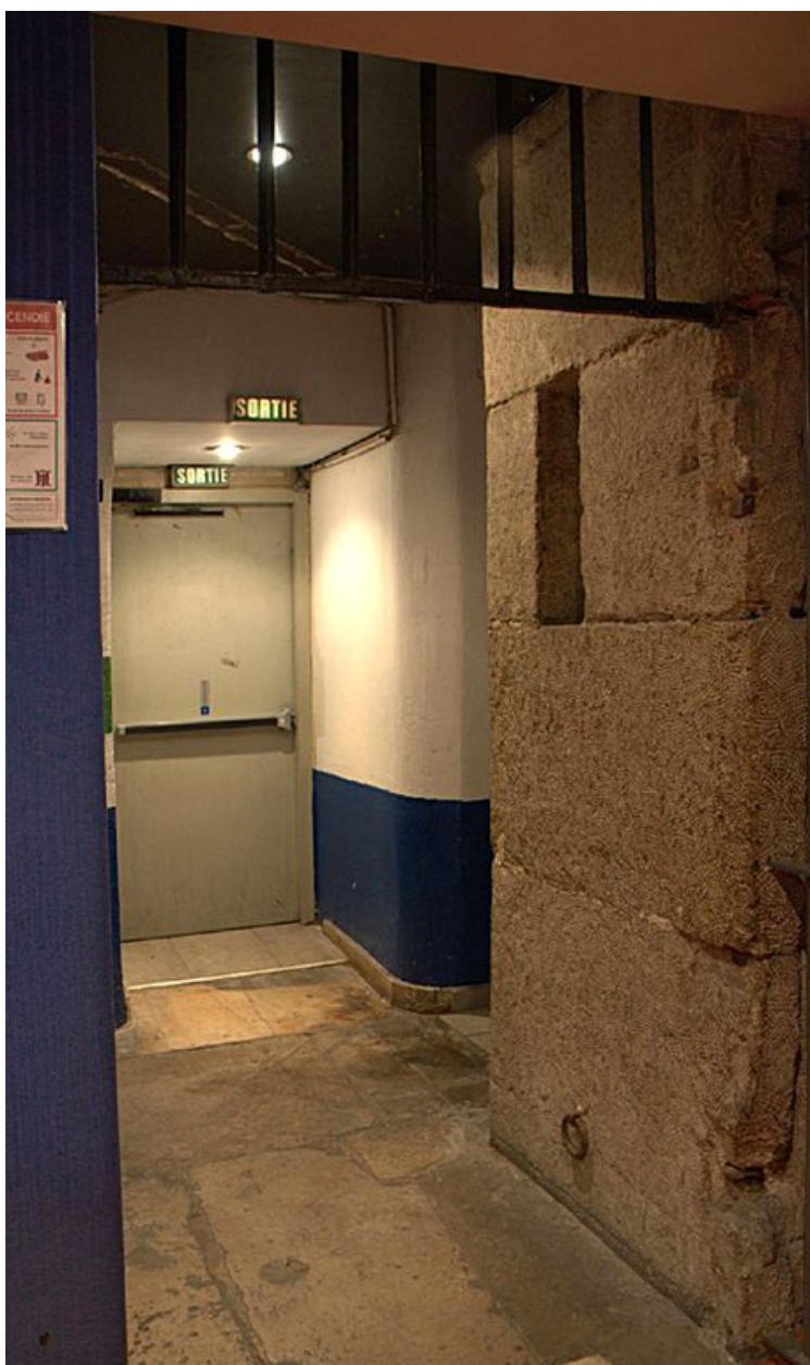
Ancienne allée et mur porteur au débouché de l'escalier en équerre desservant le sous-sol (actuel escalier de sortie de la salle1 du cinéma)
