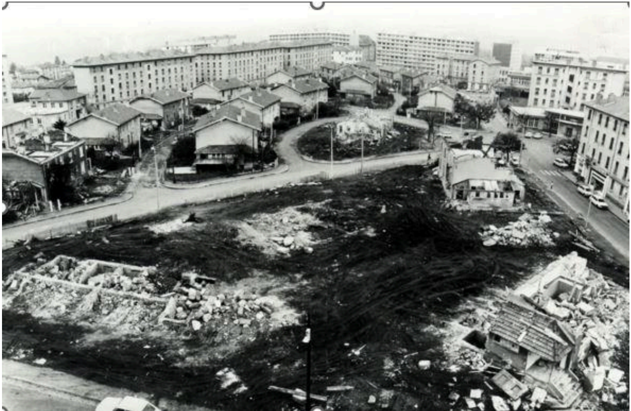
Photo de 1972 : démolition des maisons de la cité ouvrière (BML)
