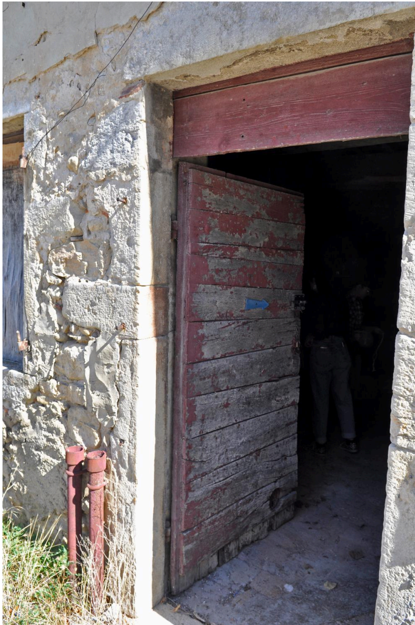
Porte piétonne, vue extérieure
