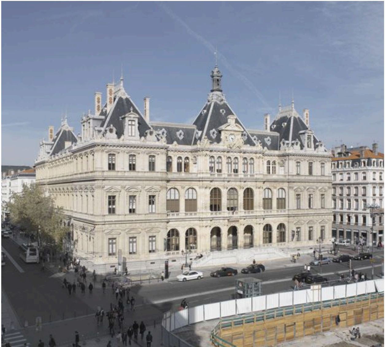
Vue depuis le sud-ouest après la démolition du Grand Bazar
