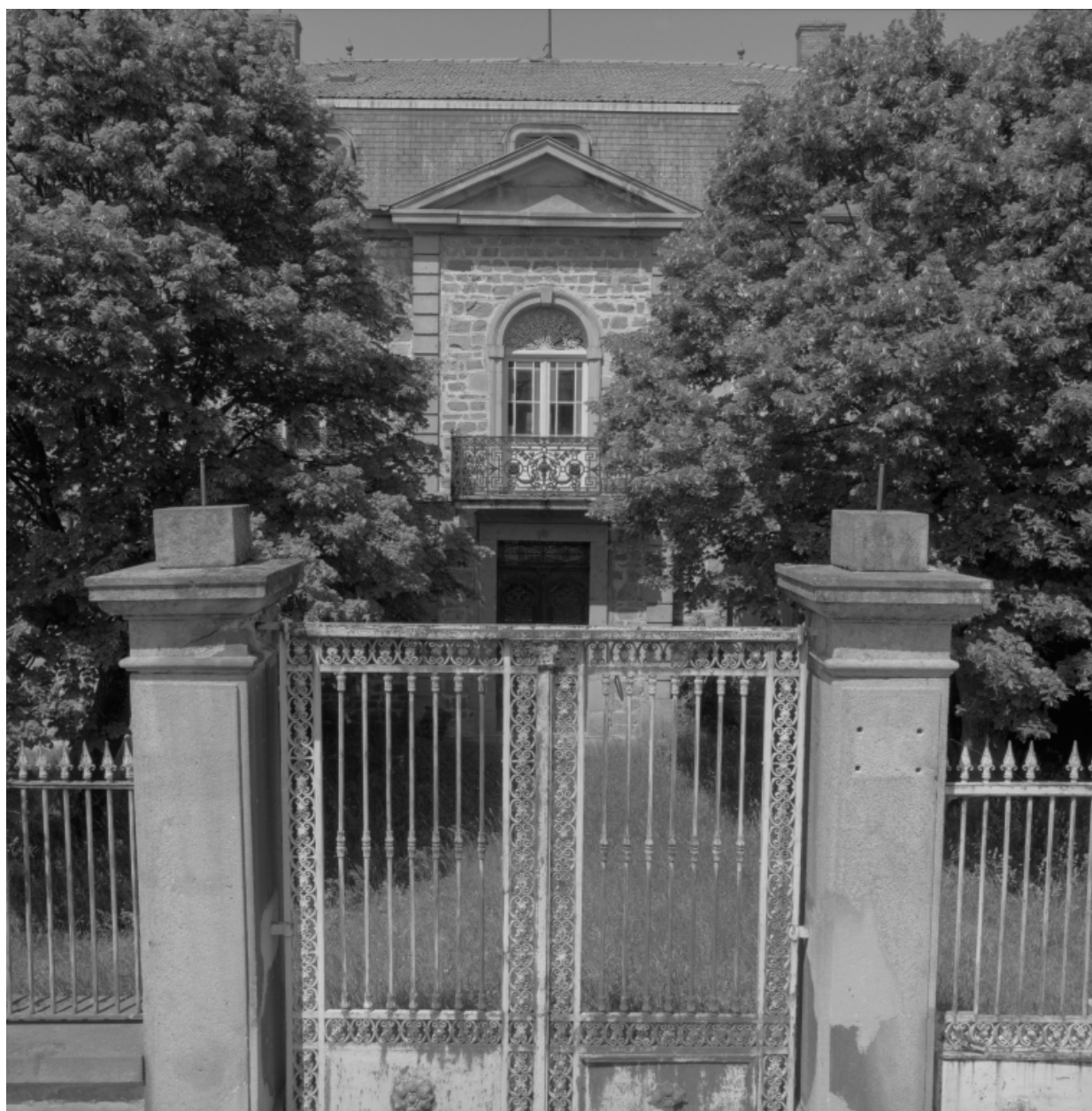
Vue depuis le sud : portail d'entrée et façade antérieure.
