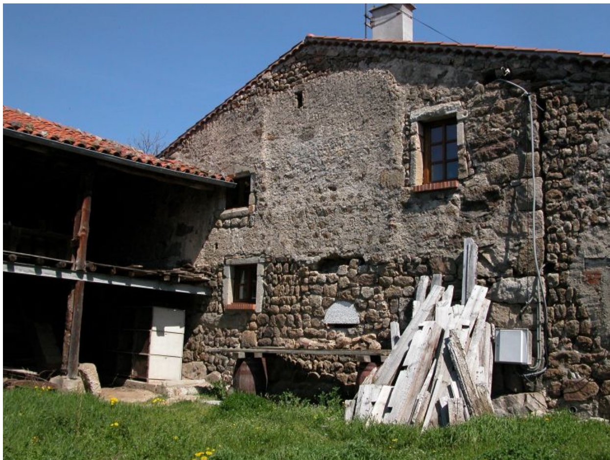
Vue d'ensemble du mur pignon est du logis.
