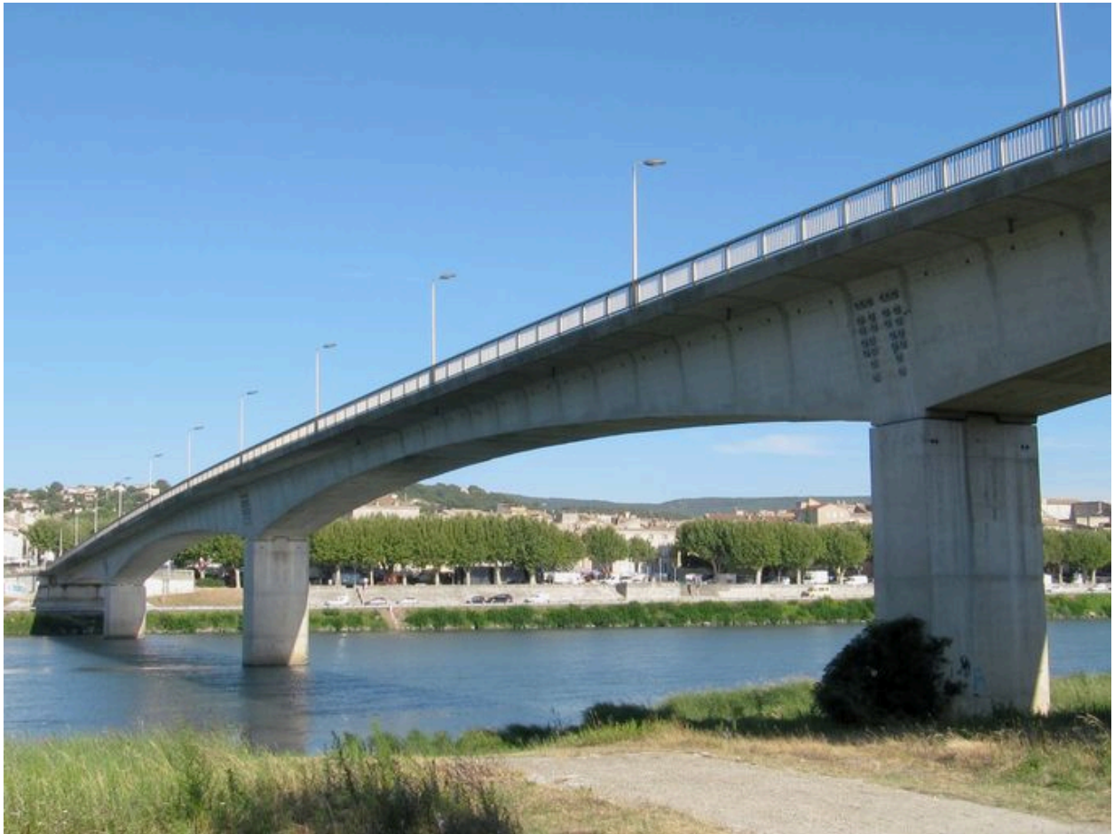
Vue partielle, de côté, face aval (depuis la rive gauche)
