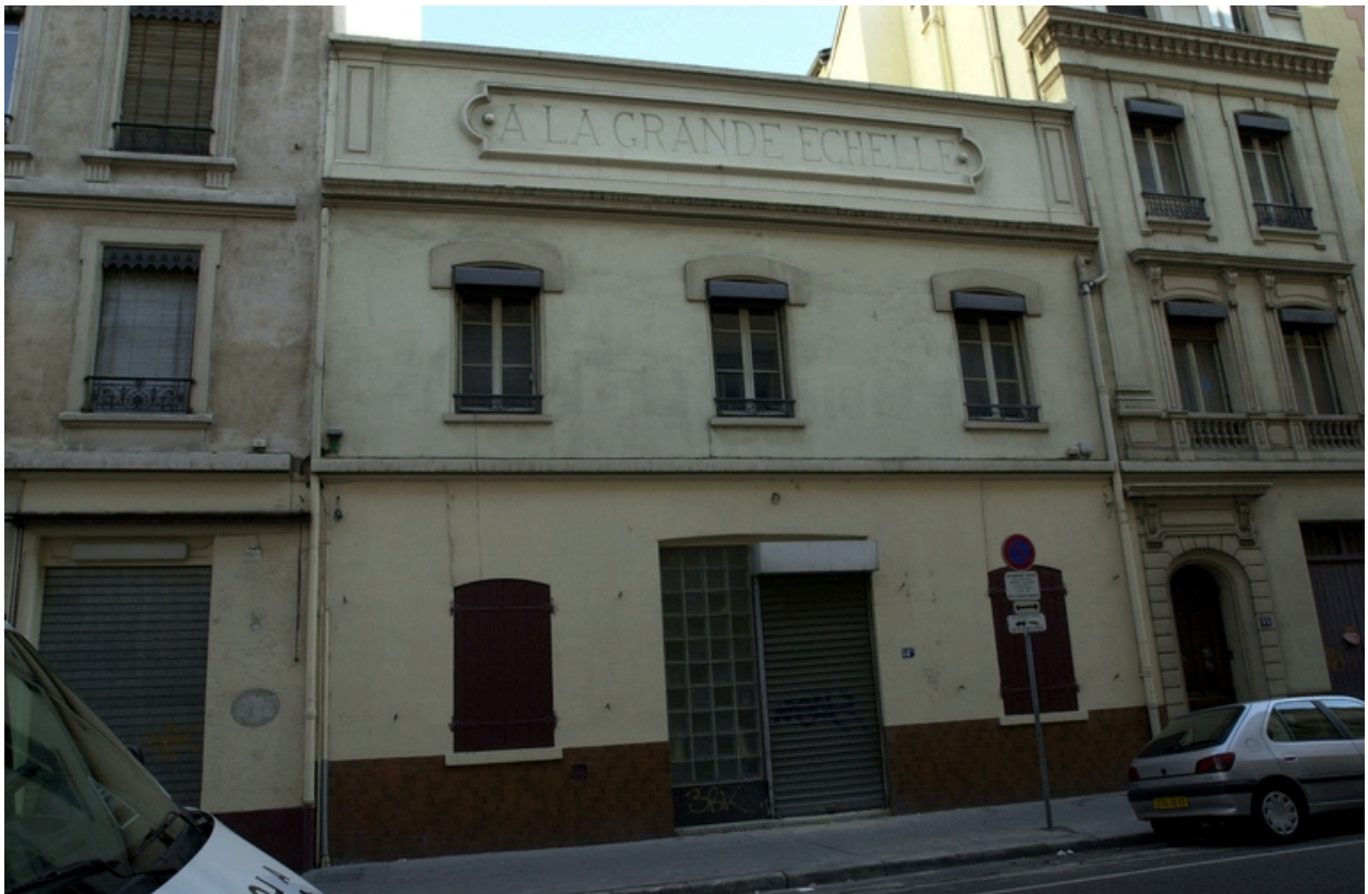
Vue d'ensemble de la façade est
