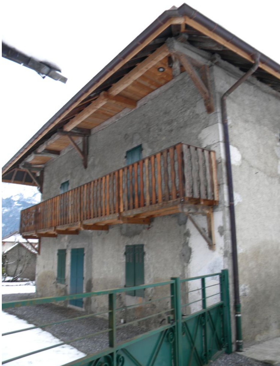
Vue du pignon sud avec balcon contemporain.
