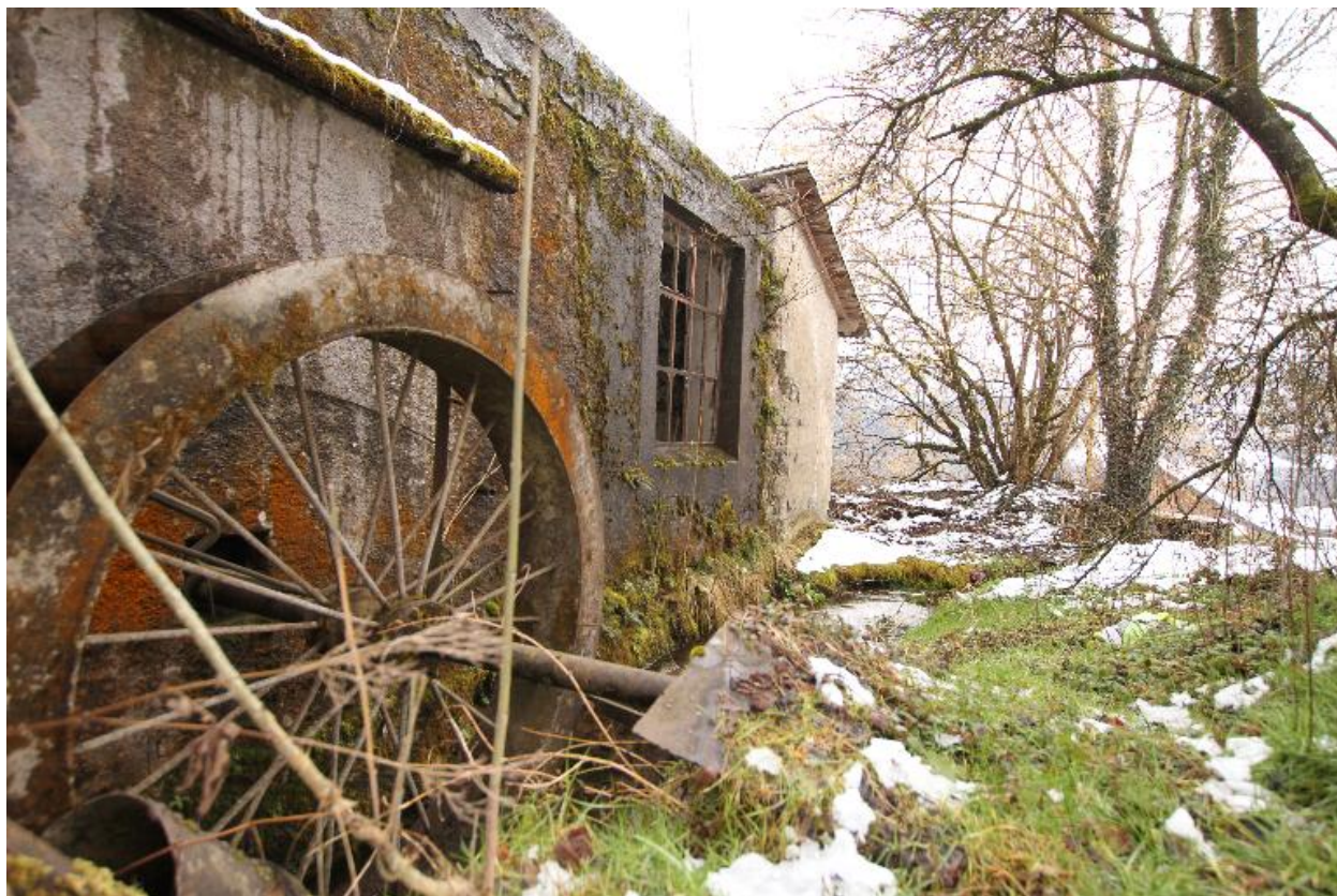
Détail de la roue hydraulique adossée au mur latérale ouest de la forge
