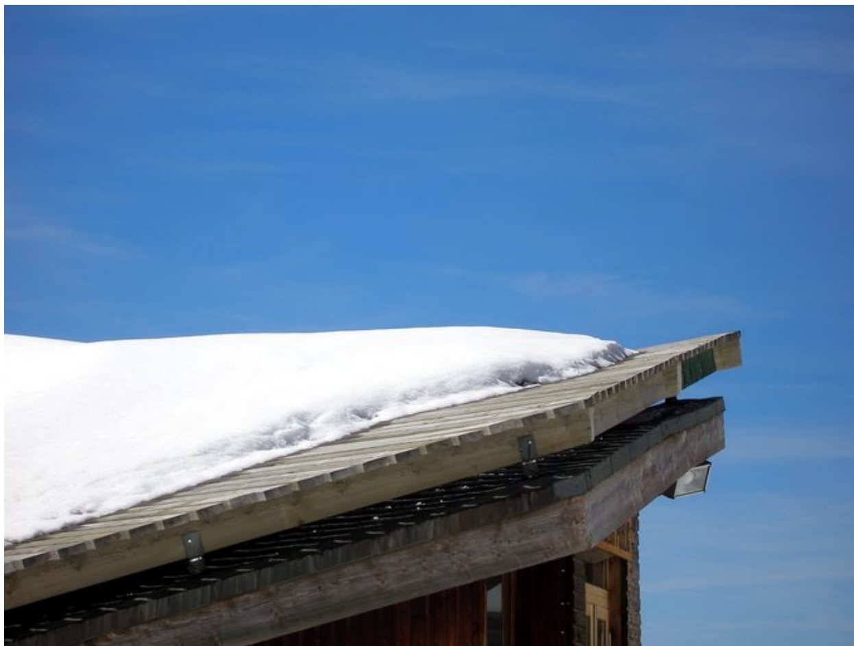
Détail de la bordure de toiture
