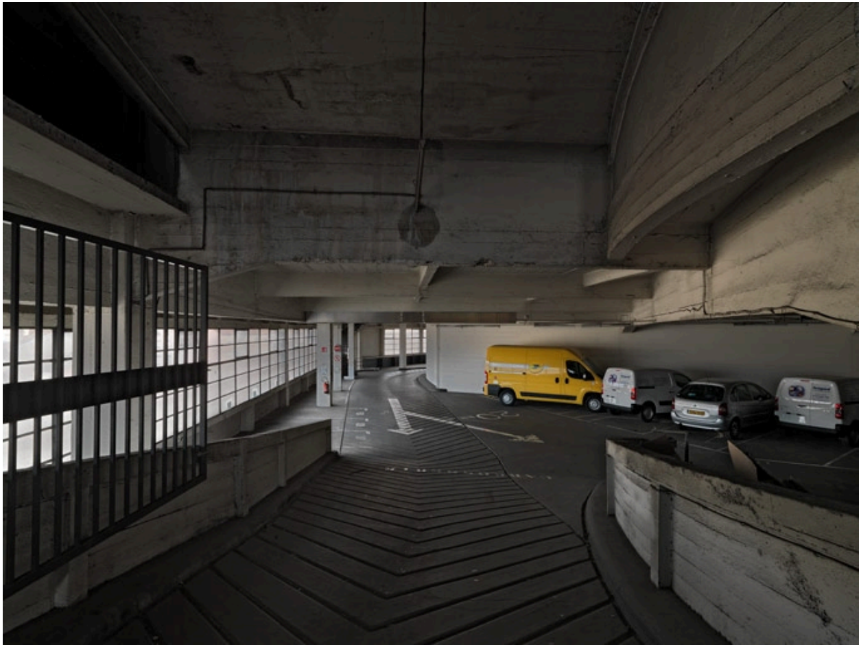
Rampe descendante du 5e au 4e étage
