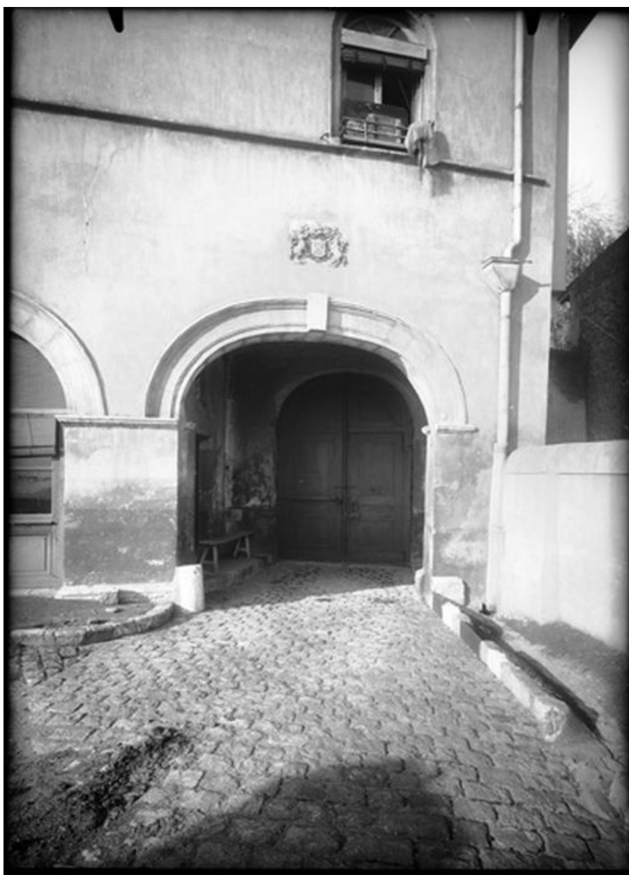
Vue des Chazeaux - Archivolte de l'ancienne porte sur Montée St-Barthélemy, fotogr. par l'abbé Amphoux, ca 1920-1940
