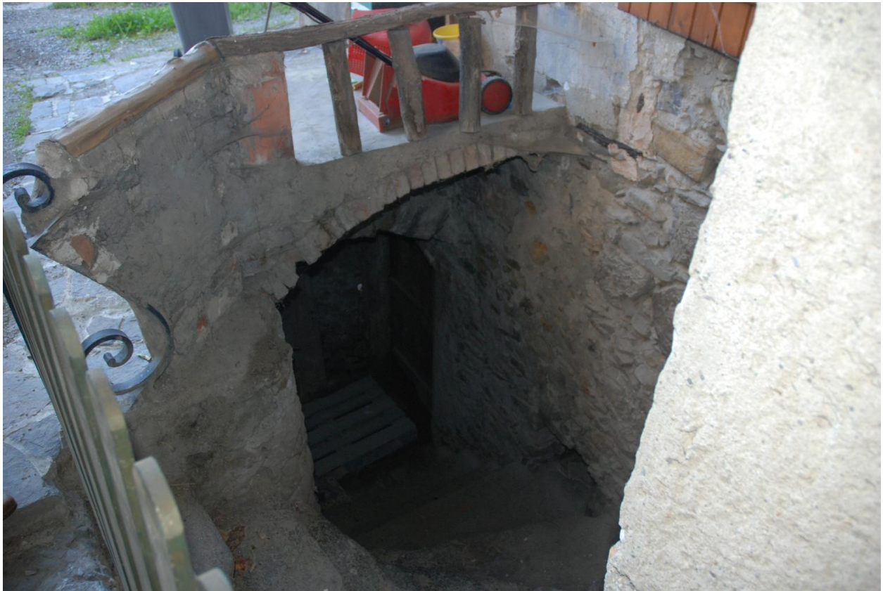
Maison de vigneron (2018 D3 781 nord). Descente de cave sous une voûte en brique puis en pierre.
