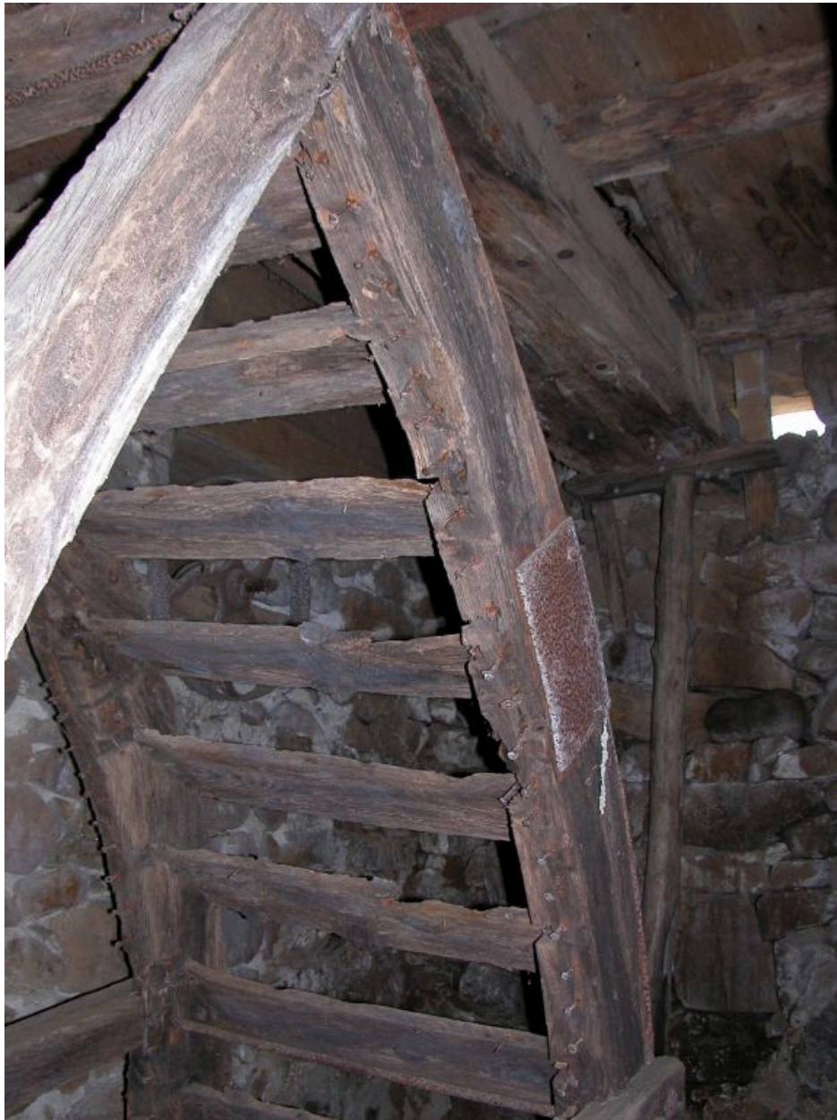
Façade ouest du moulin, détail roue à aubes.
