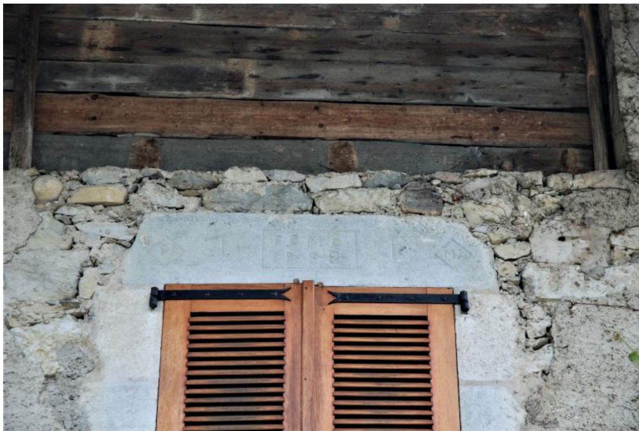
Détail du linteau de la porte-fenêtre au 1er étage.
