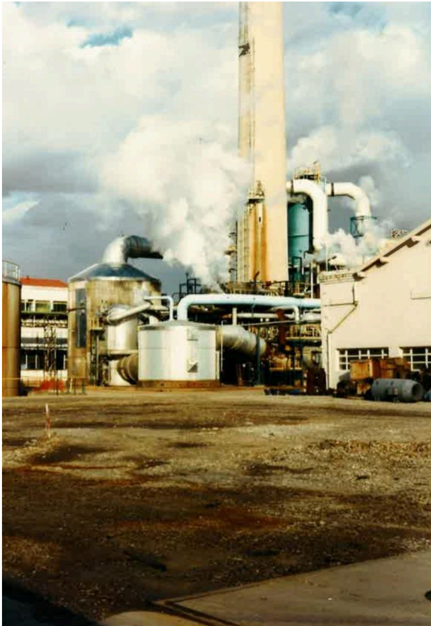
Usine Elf Atochem à Saint-Fons en 1996 (©Métropole de Lyon : 7152WM 509)
