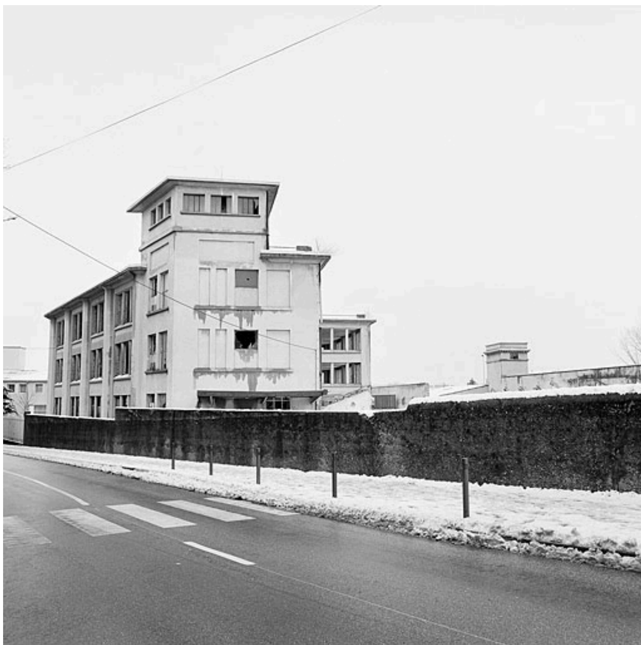
Vue arrière du bâtiment
