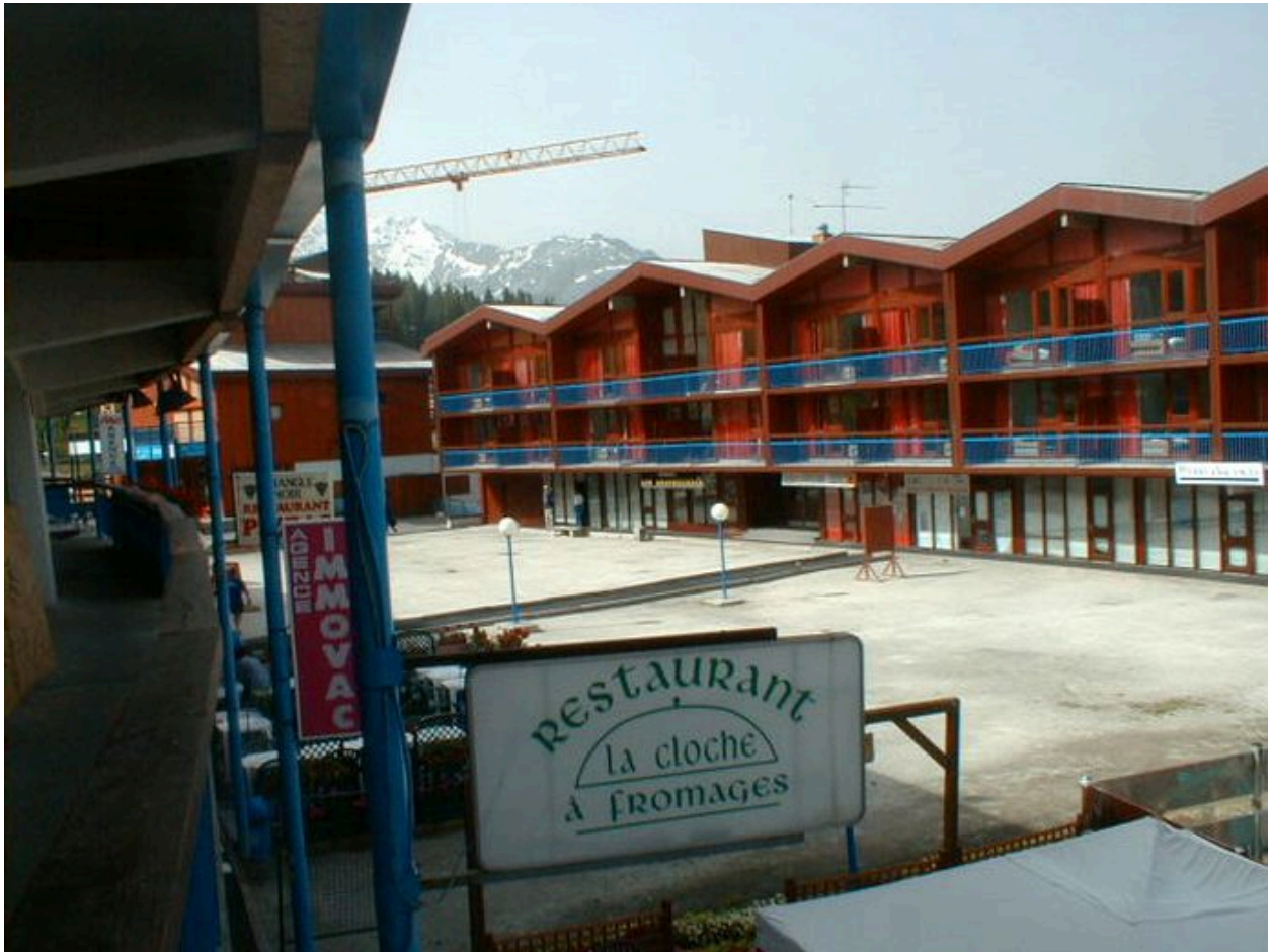
Façade est (amont) depuis la place des Arandelières
