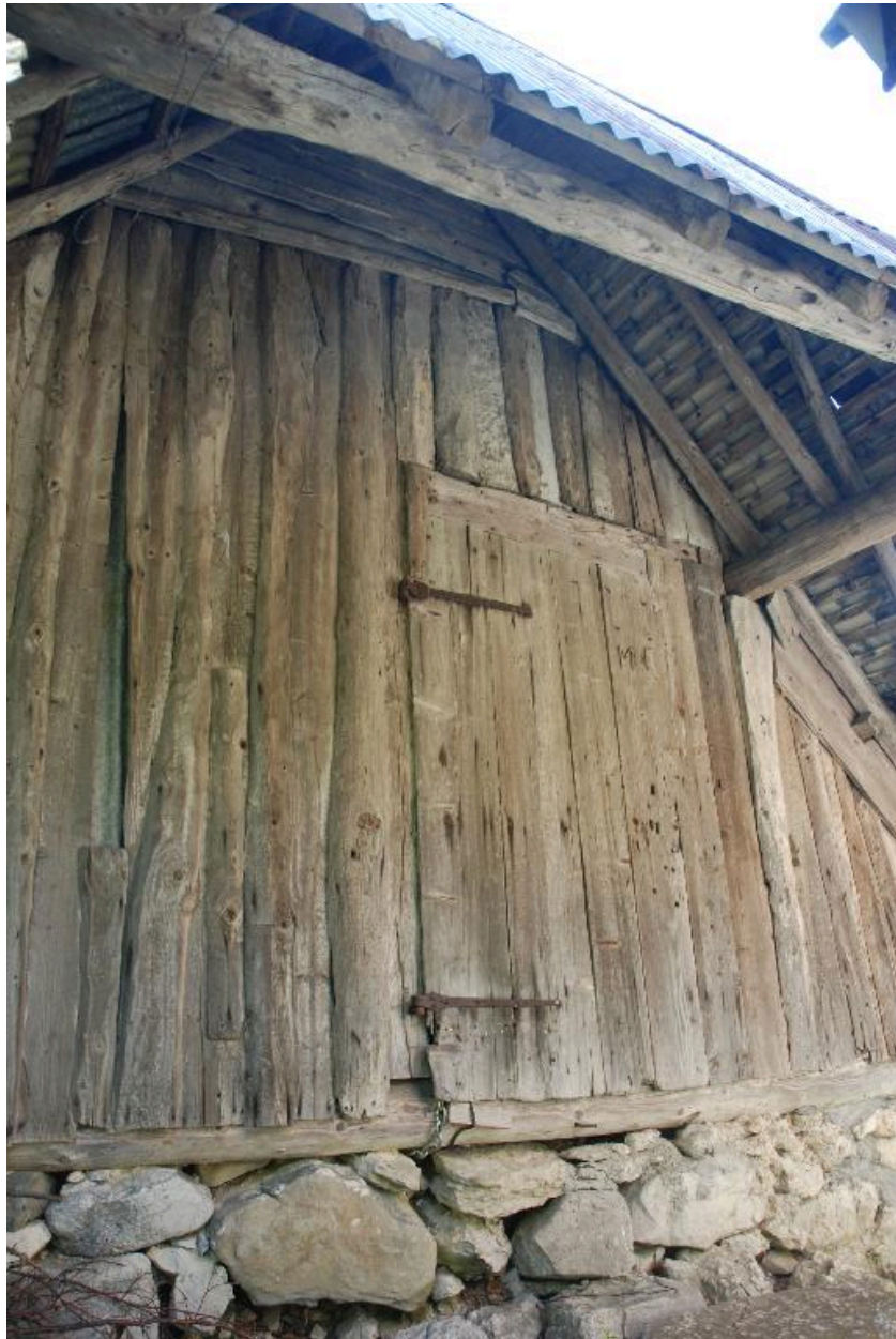
Détail du pignon nord.
