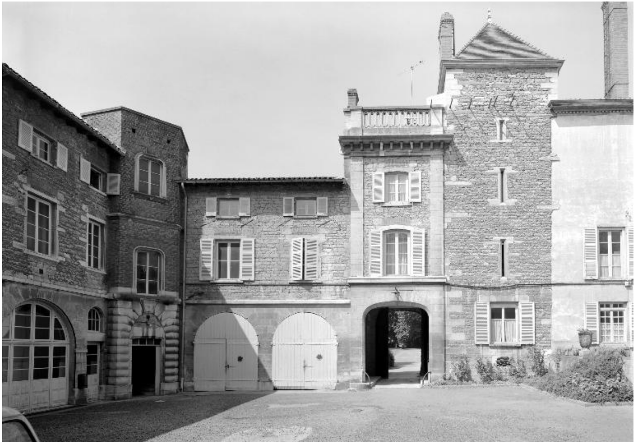
Elévations sur cour, angle sud-ouest
