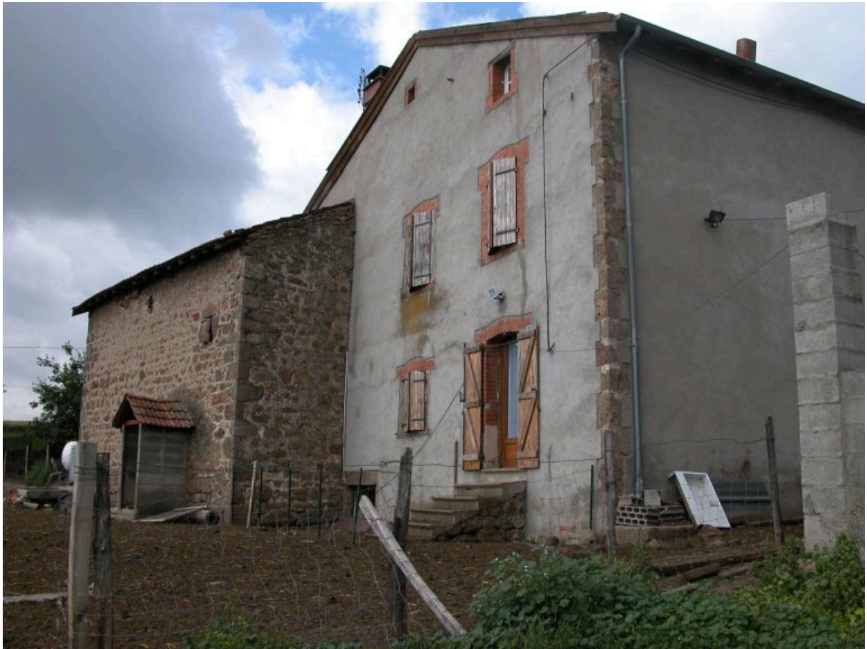
Vue d'ensemble du mur pignon droit du logis.
