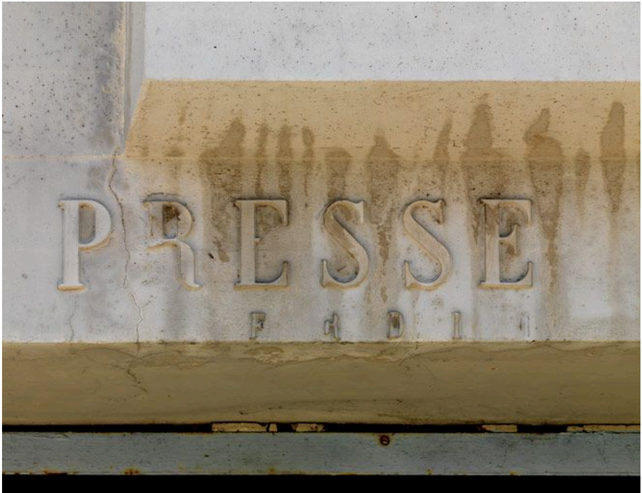
Partie sud de la piscine : détail du bâtiment réservé à la presse (état en juin 2012).
