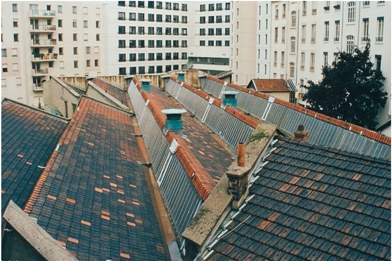
Vue zénithale nord-ouest
