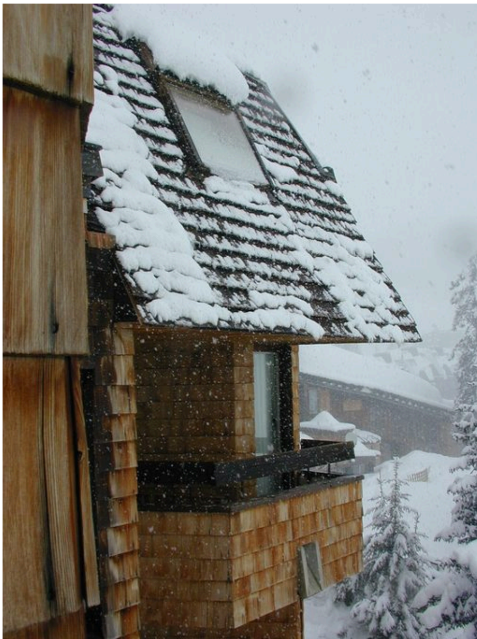
Façade sud : les terrasses protégées par les toits
