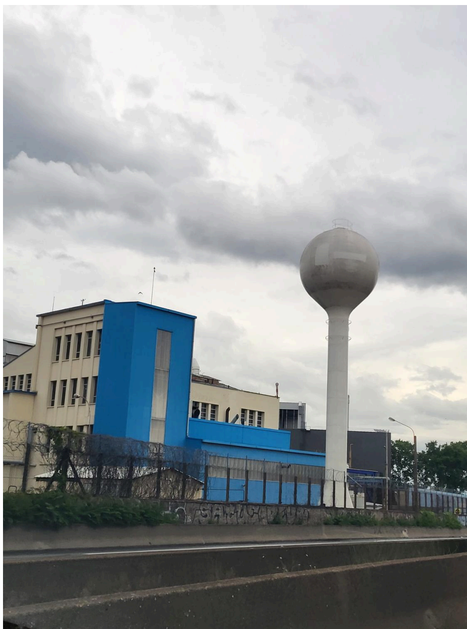
Château d'eau circulaire Solvay nord
