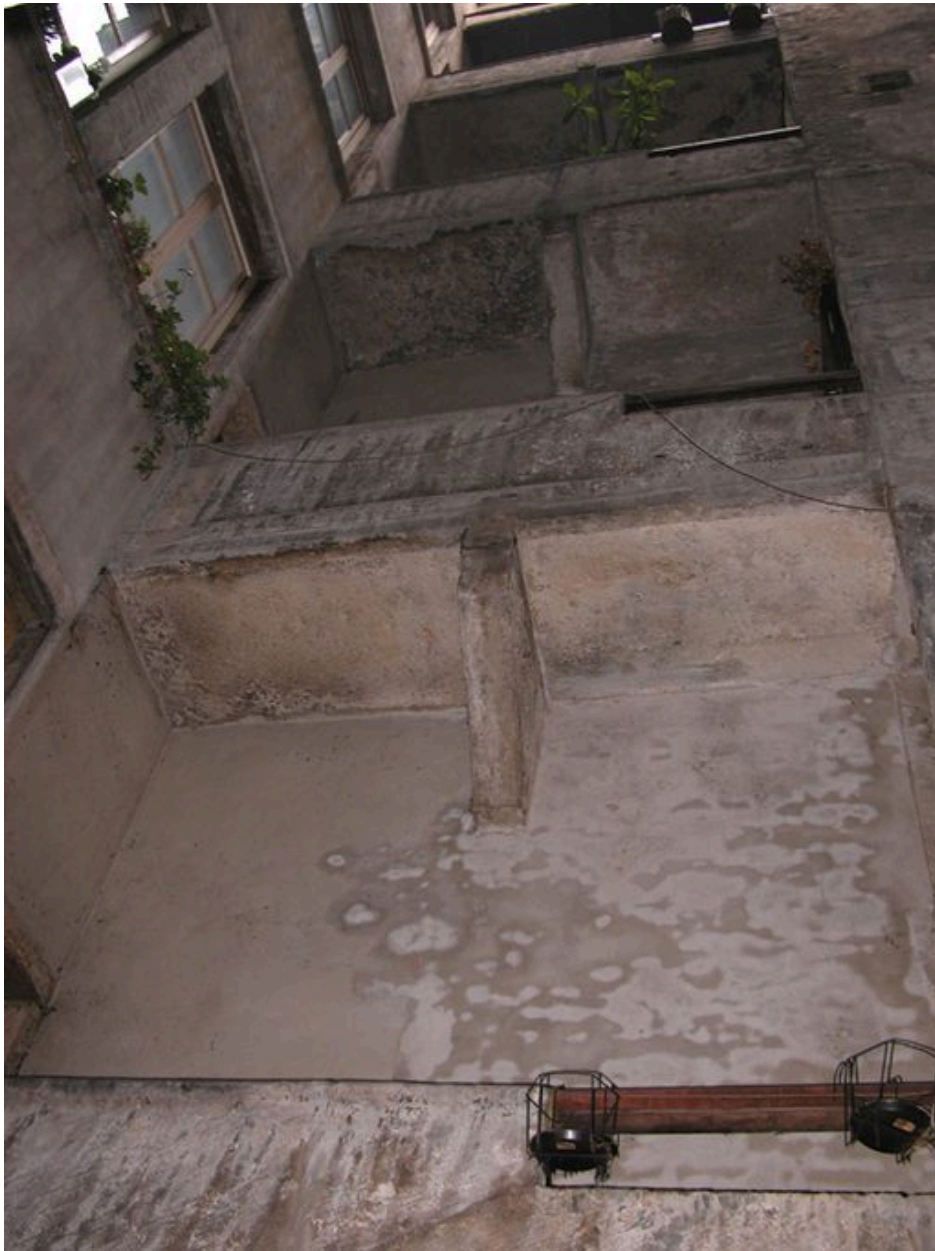
Les galeries depuis le rez-de-chaussée
