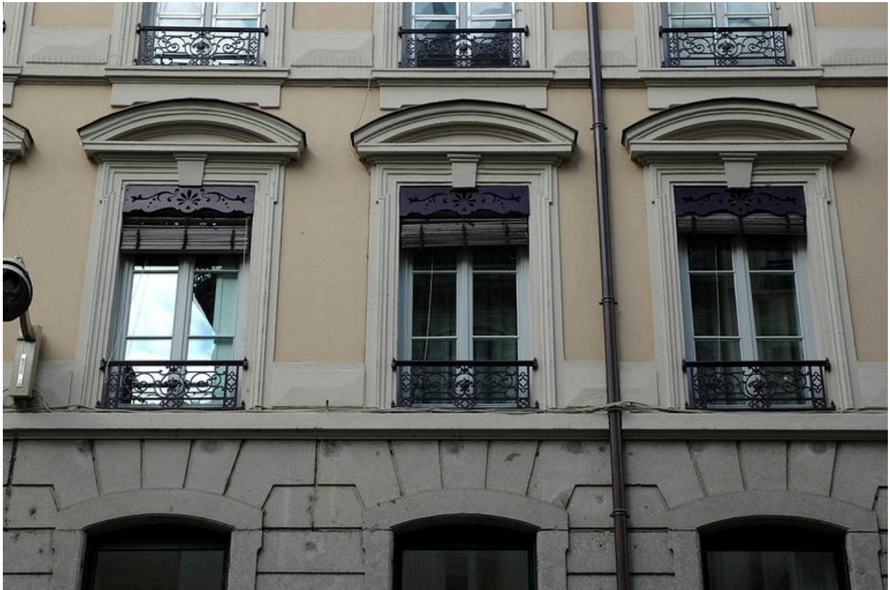
Premier étage carré : baies à fronton cintré
