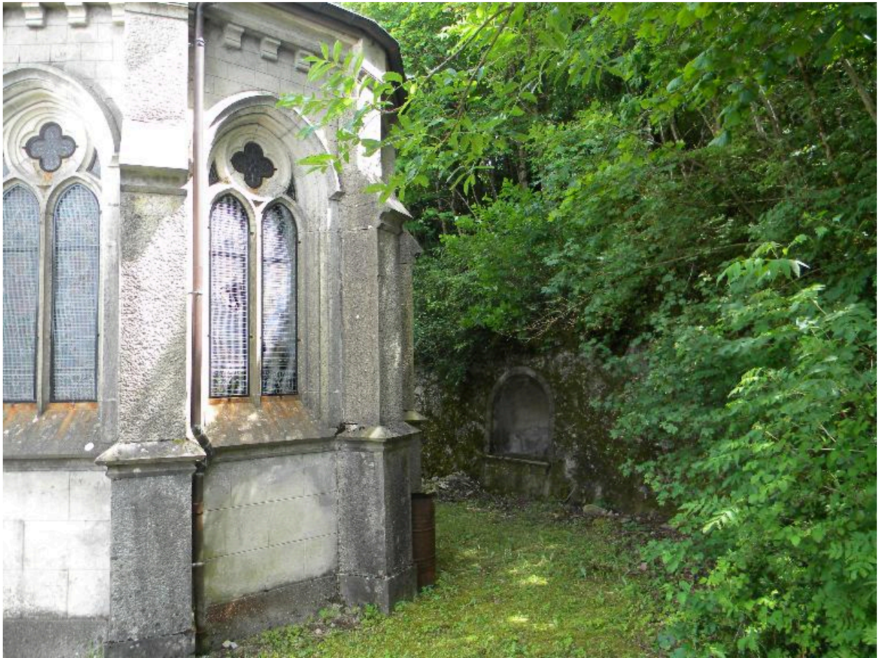
Vue de la partie sud du chevet
