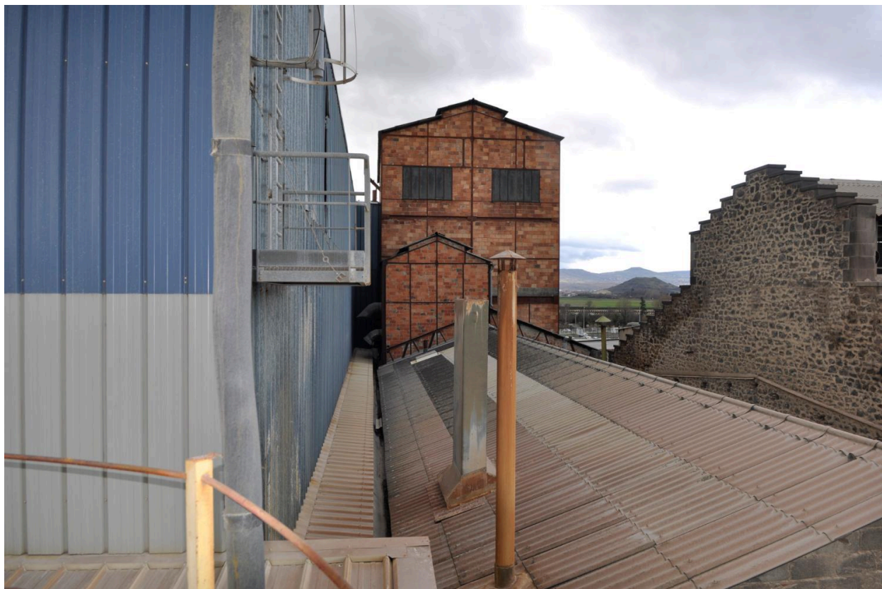
Vue de l'extérieur : tour de lavage
