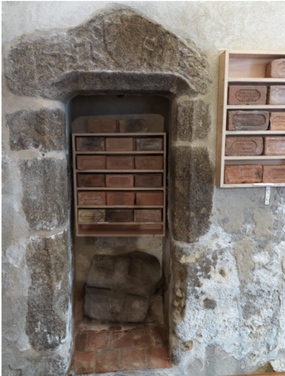
Vue du fragment de dalle funéraire (?) dans l'encadrement de la porte sud de la pièce située au nord-ouest de l'aile ouest des bâtiments conventuels.
