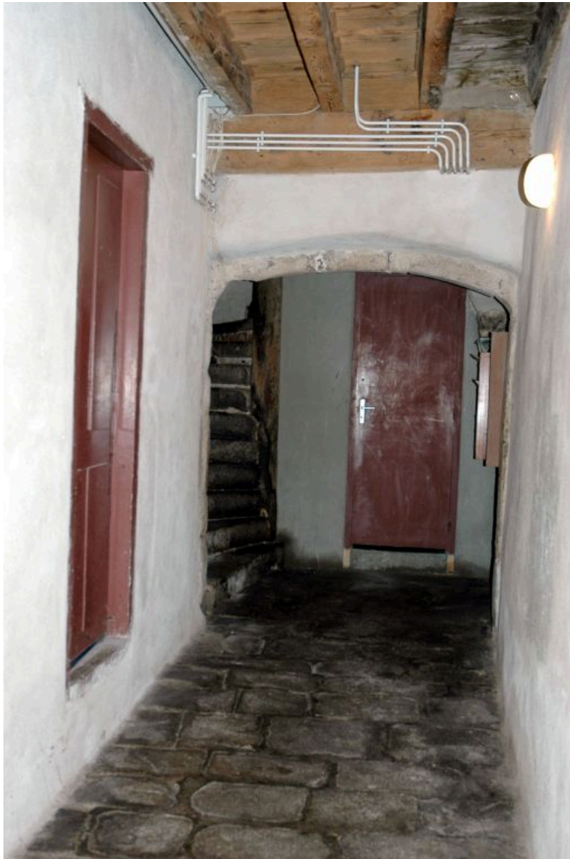
Vestibule d'entrée plafonné et sol dallé.
