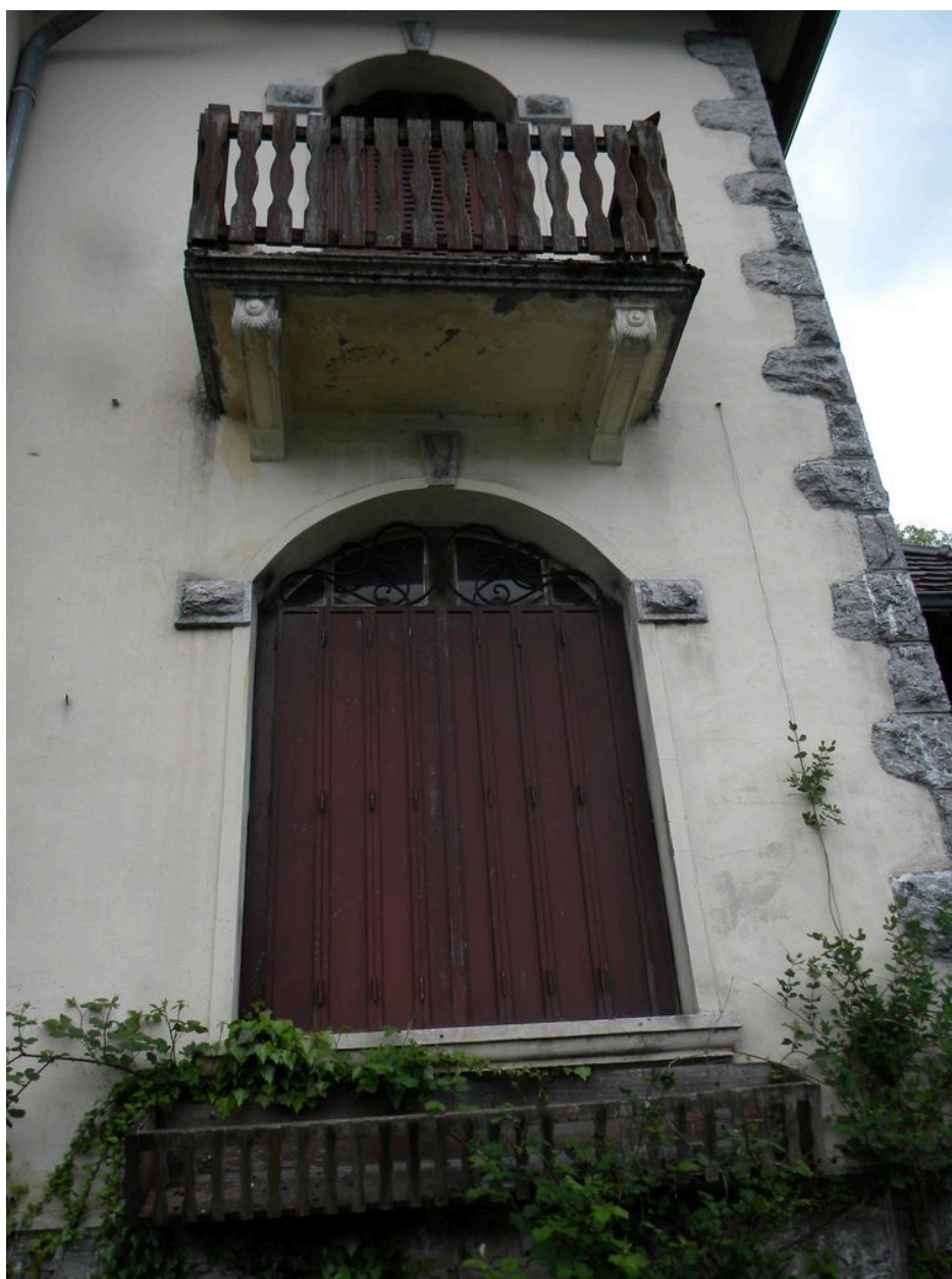
Vue d'un balcon en façade principale
