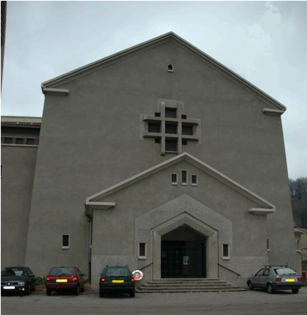
Facade principale depuis le sud-ouest
