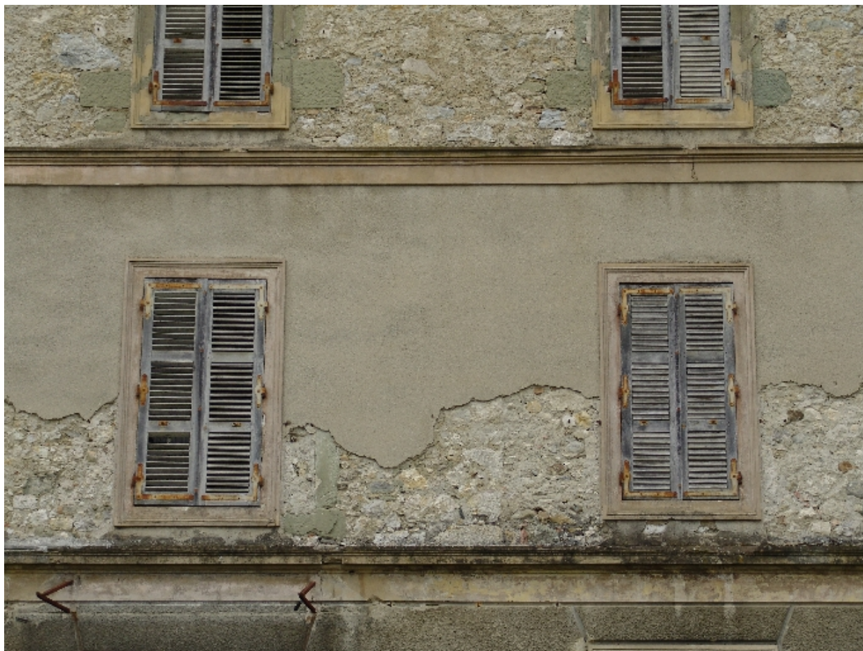
Détail de la façade
