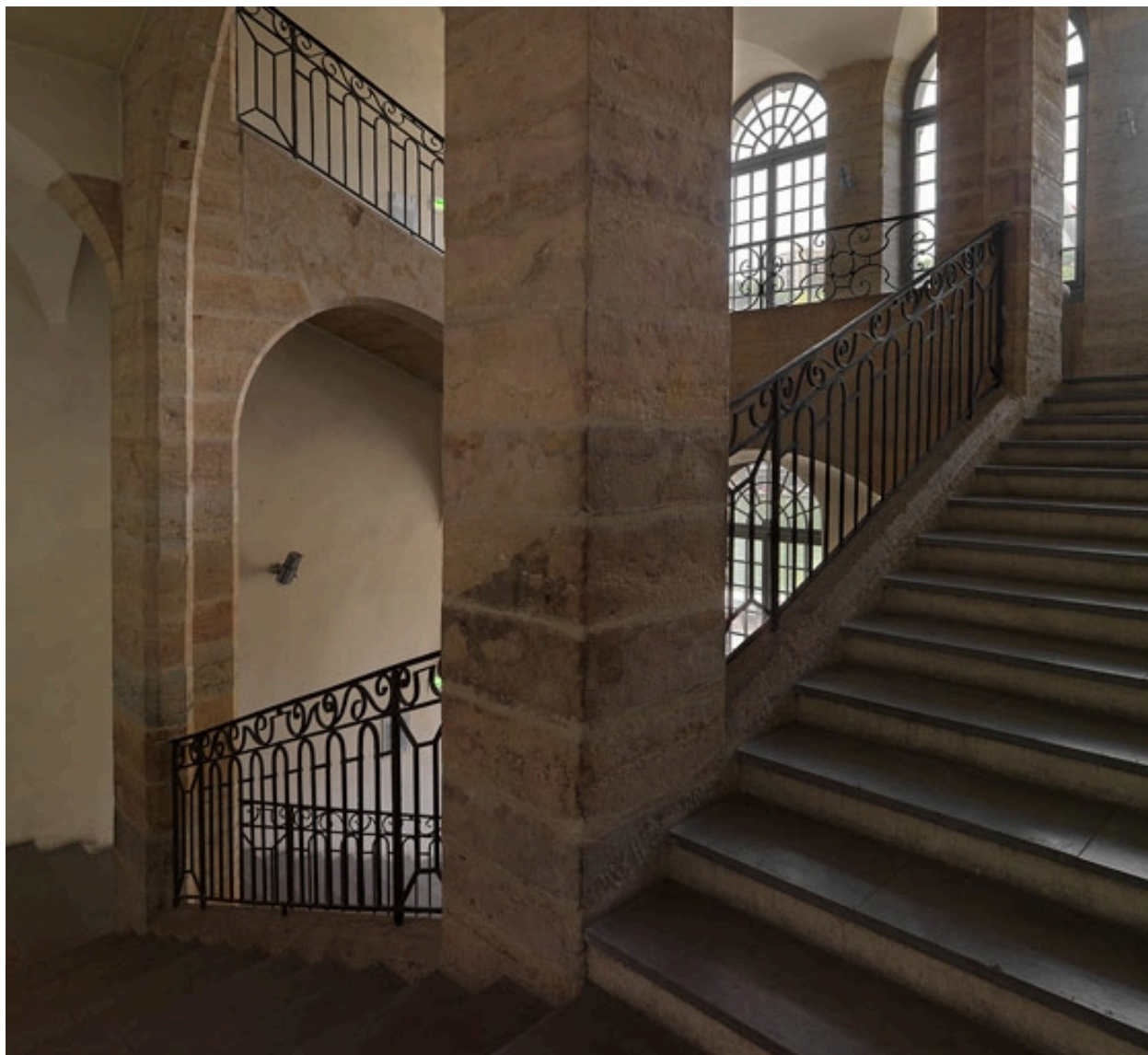
Escalier axial MH.
