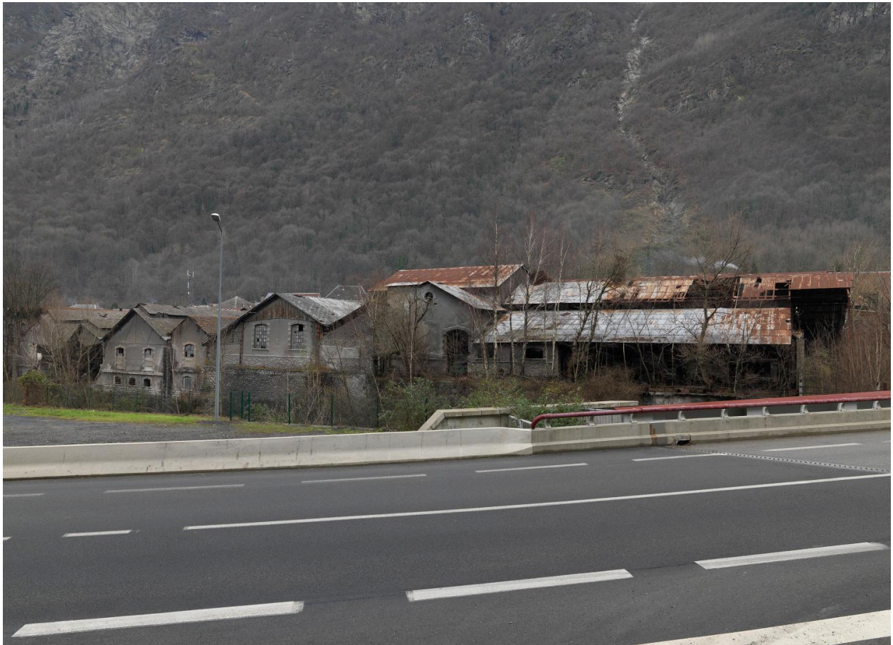
Vue des ateliers des usines Keller restant aujourd'hui à Livet
