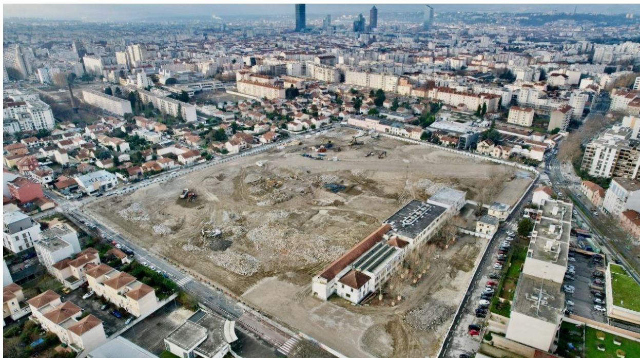
ACI, Vue après démolition (©Métropole de Lyon)
