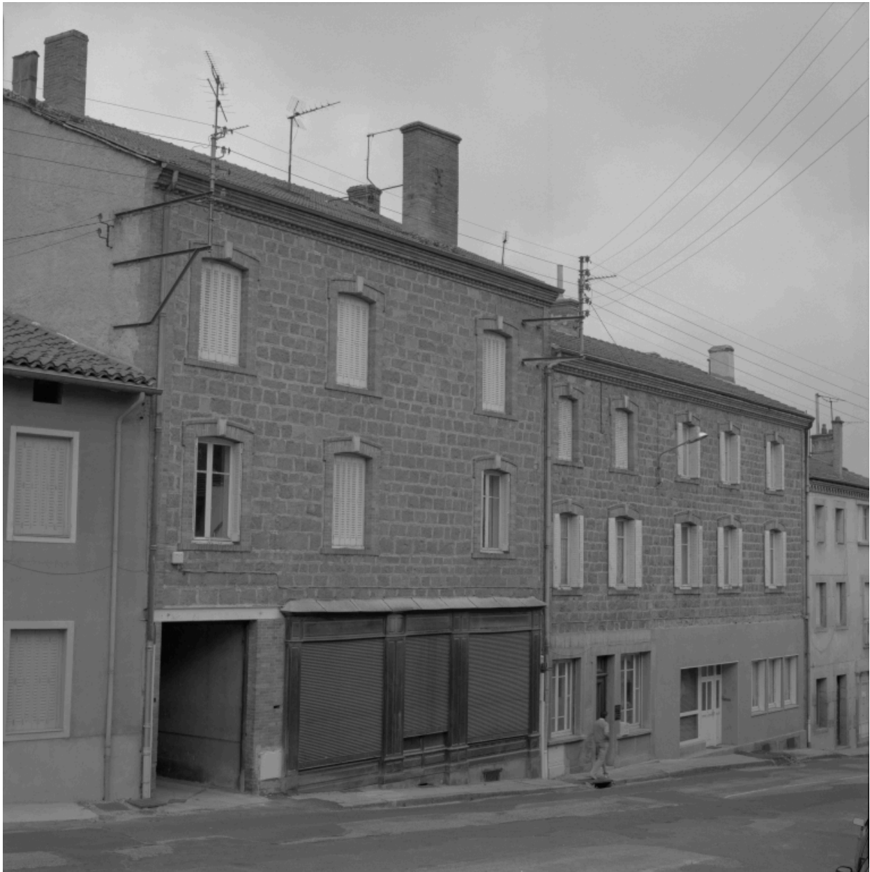
Vue d'ensemble de la façade principale depuis la route.
