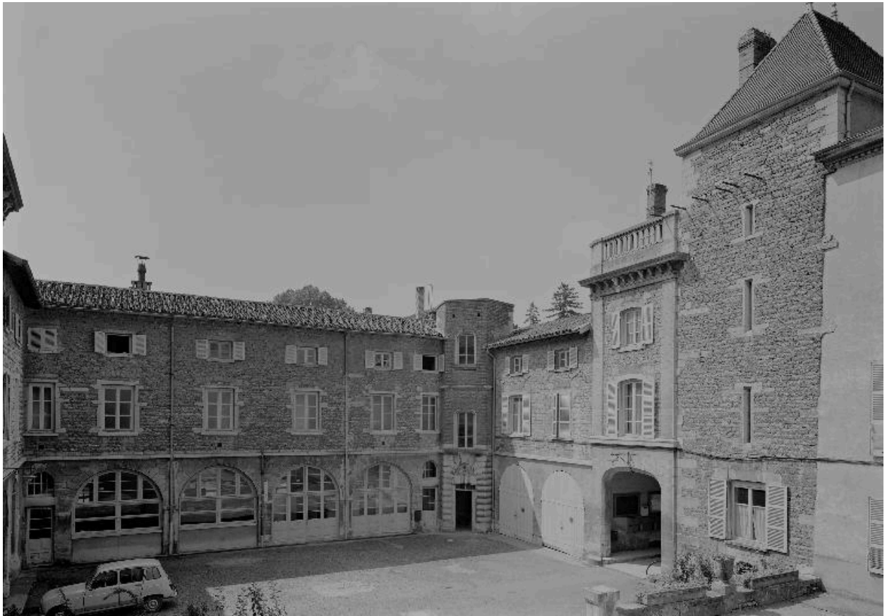
Anciens communs convertis en bâtiments scolaires, élévations sur cour
