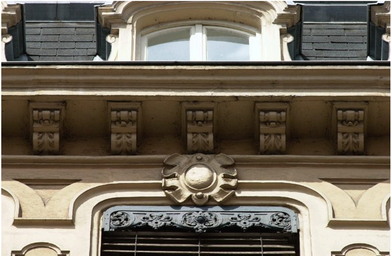
Elévation est, quatrième étage carré : corniche et fenêtre
