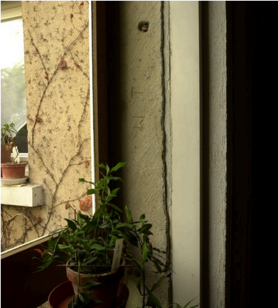
Détail de la marque de tâcheron M T gravée dans un encadrement de fenêtre
