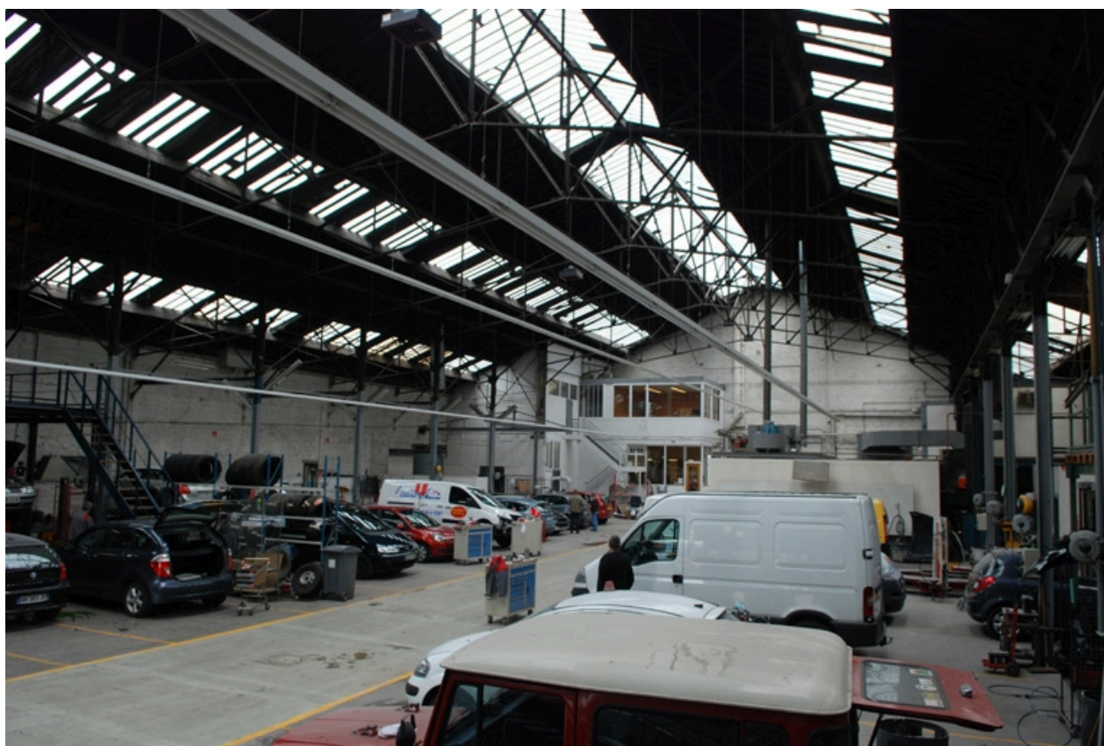
Vue intérieure d'ensemble
