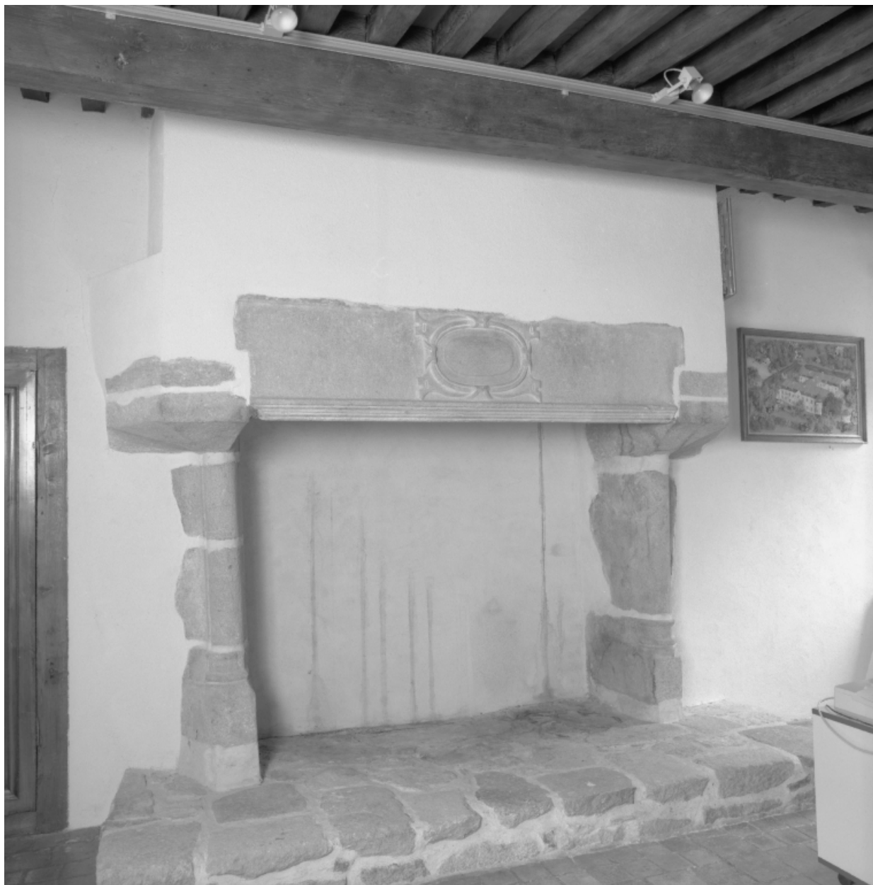
Corps de logis sud-ouest, rez-de-chaussée, pièce située entre l'ancienne cuisine et la chapelle : vue intérieure de la cheminée (linteau trouvé dans les communs et remonté).
